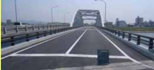
補強工事完了後の網干大橋
