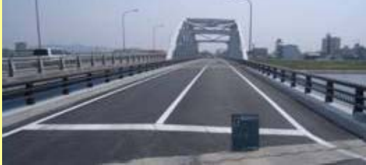
補強工事完了後の網干大橋
