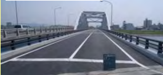
補強工事完了後の網干大橋
