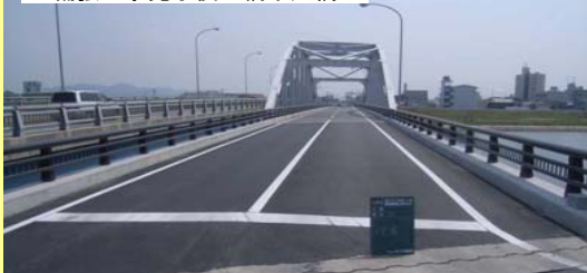
補強工事完了後の網干大橋
