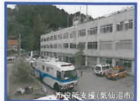
排水ポンプ車による排水作業(東松島市)
