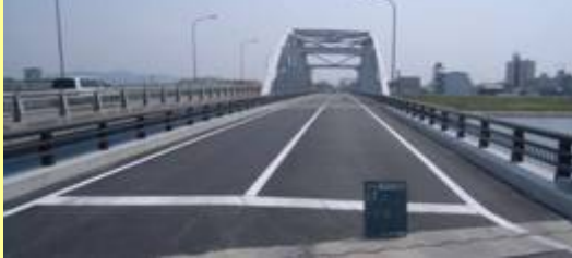
補強工事完了後の網干大橋
