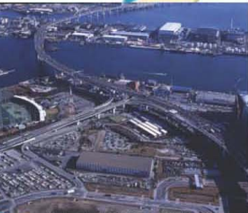
阪神高速道路湾岸線(尼崎末広ランプ付近)
