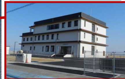
近畿圏臨海防災センター(支施設棟) (平成24年4月1日供用)
