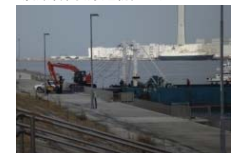
フェリーバージによる復旧用重機搬送
