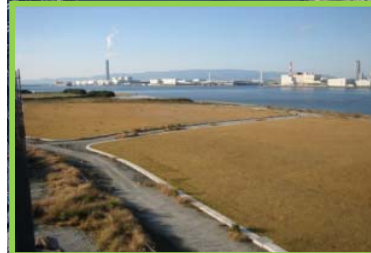
防災緑地 面積: 27.9ha (平成24年4月1日供用)
