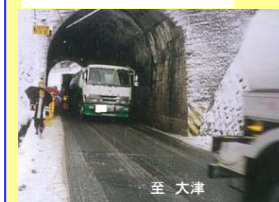
疋田トンネル
