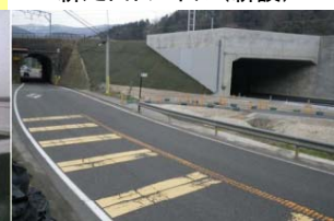
新疋田トンネル(新設)
