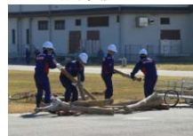
近畿地整職員による道路啓開
