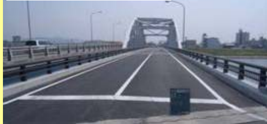
補強工事完了後の網干大橋
