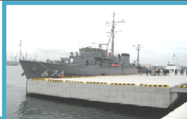
耐震強化岸壁 水深-7.5m 延長130m (平成23年度供用)
