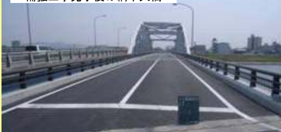
補強工事完了後の網干大橋
