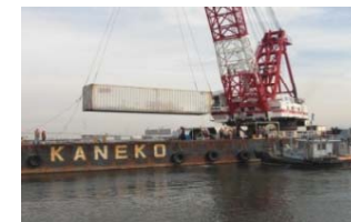
緊急確保航路内にコンテナ が流出した想定での啓開 (コンテナ回収)
