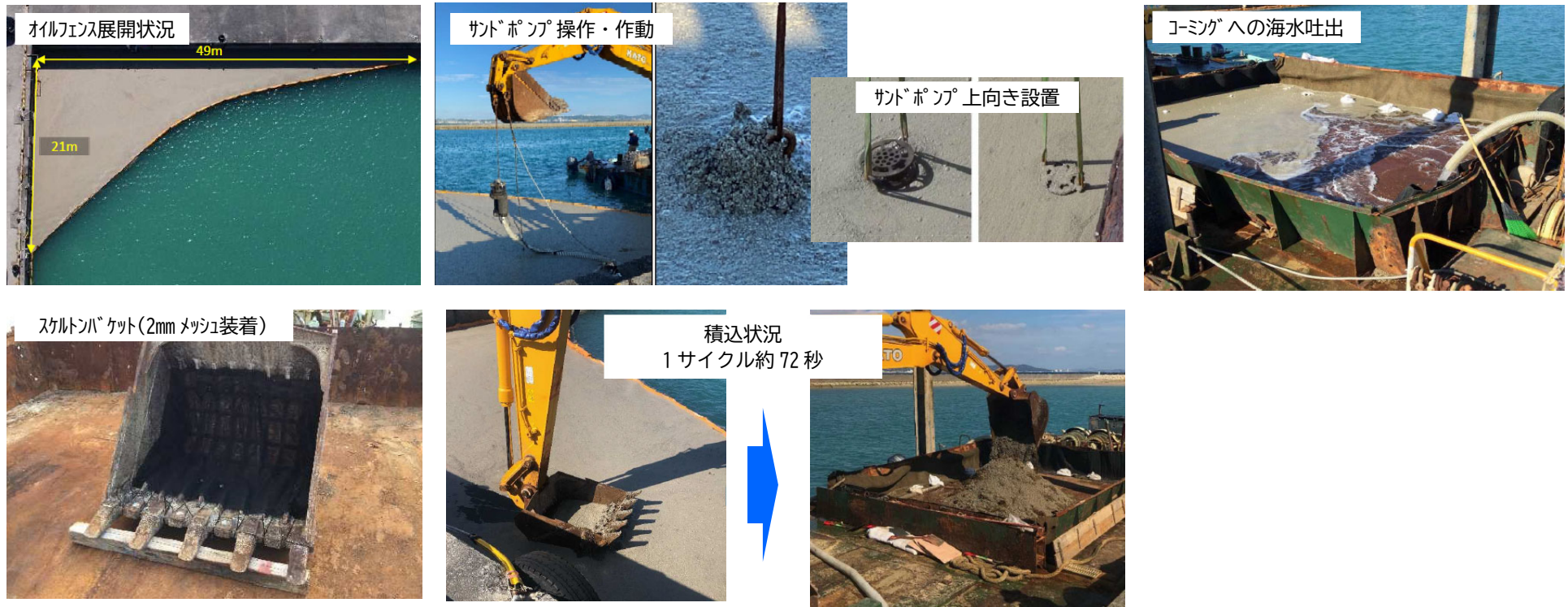
写真 2-2-2 四国地方整備局所有「美讃」と起重機船との連携作業風景
