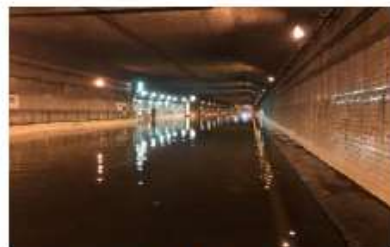
冠水するトンネル
