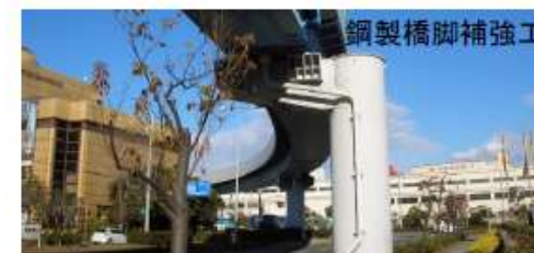
橋脚補強工
