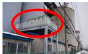
電気系設備の嵩上げ
