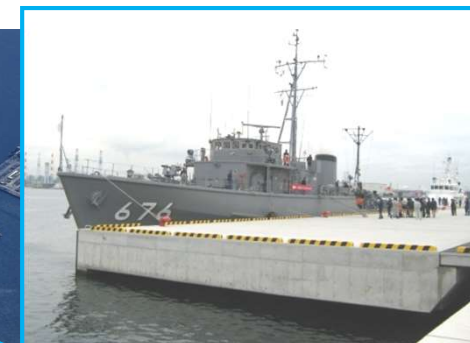
耐震強化岸壁 水深7.5m, 延長130m (平成23年度供用開始)
