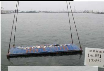
ワイヤーによる吊り上げでの揚収作業
