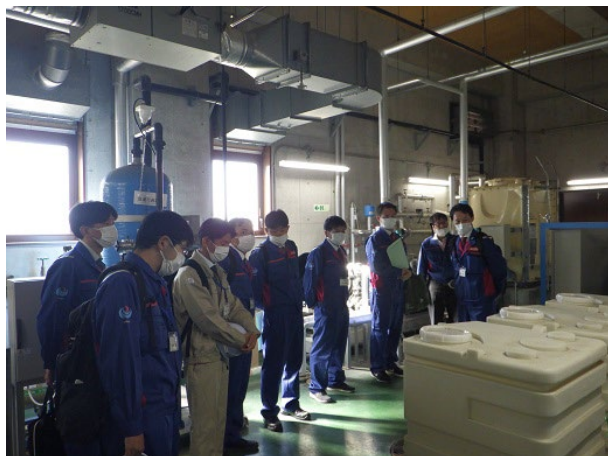
海水淡水化装置説明（支援施設棟）
