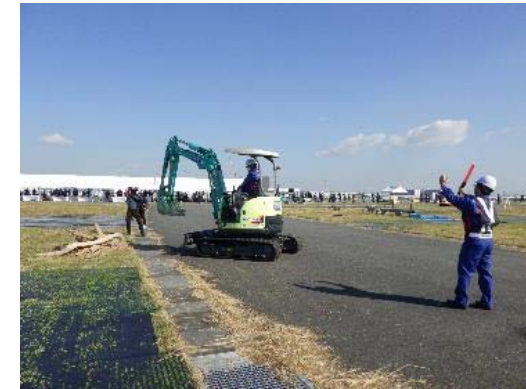
近畿地方整備局職員による 道路啓開訓練
