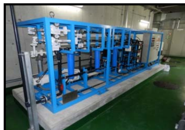
支援施設棟受水槽室 (海水淡水化装置)
