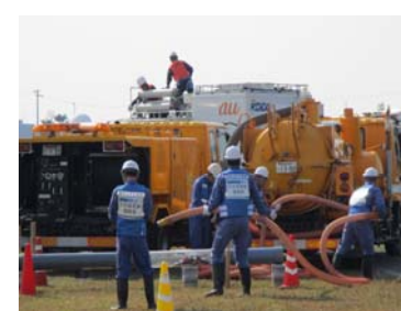
ライフライン復旧訓練
