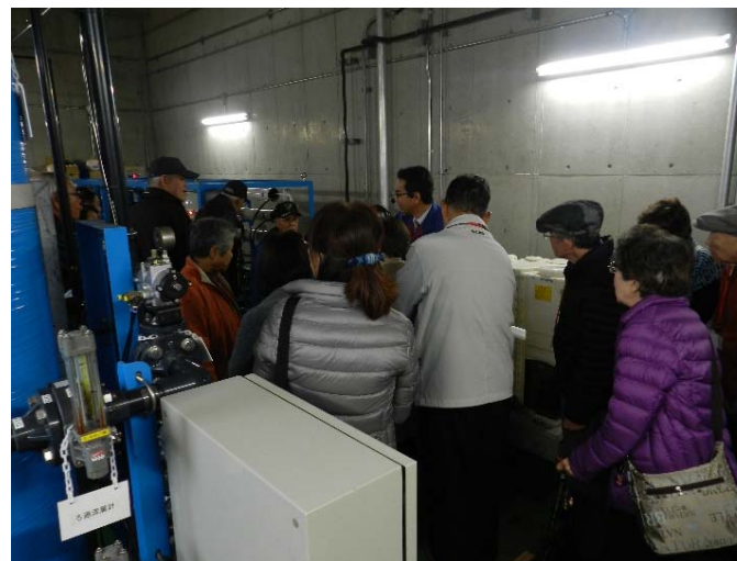
支援施設棟の海水淡水化装置を見学
