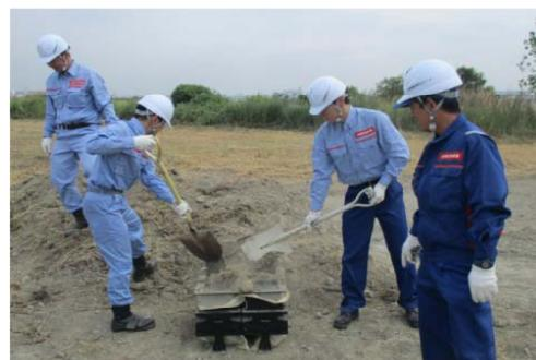
道路段差の応急復旧(土のう制作)状況
