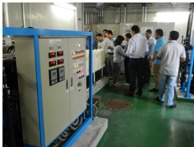
支援支援棟の海水淡水化装置を見学
