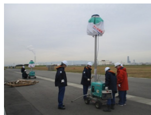
岸壁班(投光器設置)
