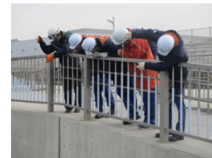
岸壁班(水深測量)
