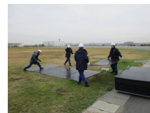
緑地班(敷板設置)
