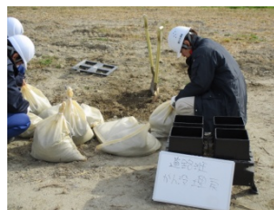
道路班(陥没埋め戻し)
