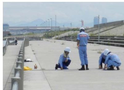
被災状況の調査・測量状況 (対策班：緑地)
