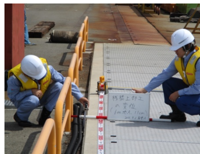
被災状況の調査・測量状況 (対策班：岸壁)
