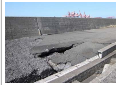
大分のコンビナート護岸の老朽化
